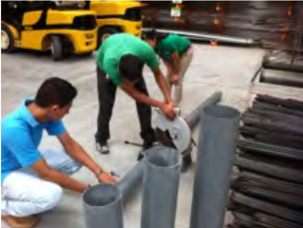
Cortamos los tubos con una sierra eléctrica
