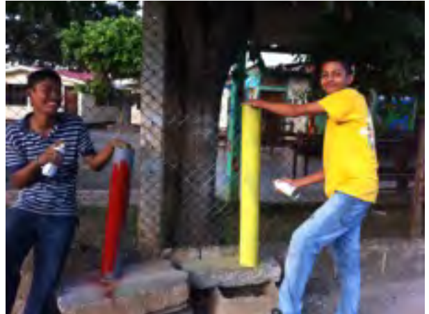
Limpiamos y pintamos los tubos
